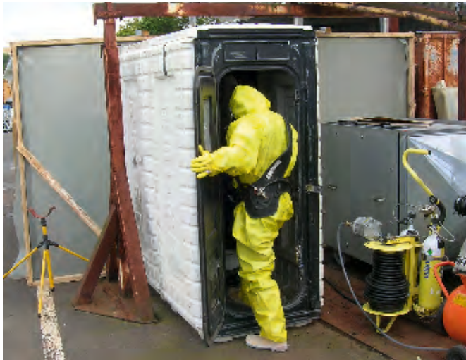
Der Mitarbeiter tritt in seinem gelben Schutzanzug in die Schleuse... ... und schließt danach sorgfältig die schwarze Tür hinter sich.
