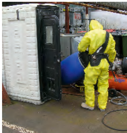
Der Wormser Sat-Spezialist mit einem blauen Fass vor der geöffneten dunklen Tür der weißen Luftschleuse, die zu dem Schwarz-Weiß-Arbeitsbereich führt.
